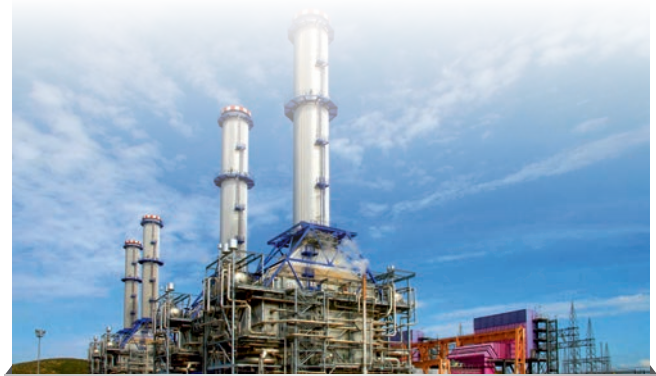
YENI ELEKTRİK 865MW CCPP-TURKEY
